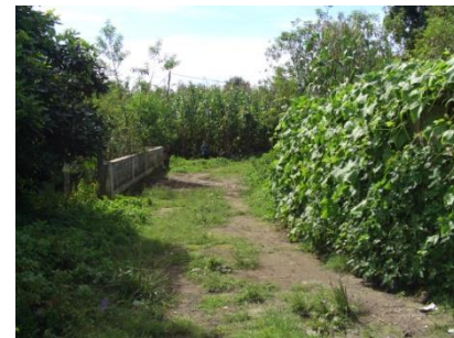
6. Ingreso angosto de tierra en mal estado.
