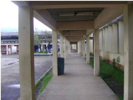
Fotografía No. 24 / Fuente: Elaboración Propia Los corredores peatonales están debidamente techados con una altura y un ancho de 2 mts.
