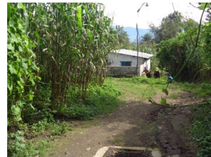
4. Calle en mal estado por falta de mantenimiento, con leve pendiente.
