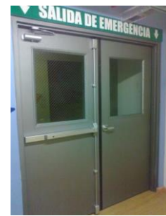
Figura 73. Salidas de emergencia.
