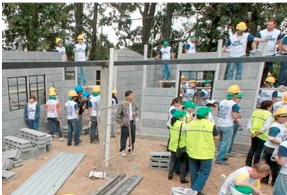
Figura 39. Construcción de escuela. Parque Las Guacamayas, Ciudad de Guatemala.
