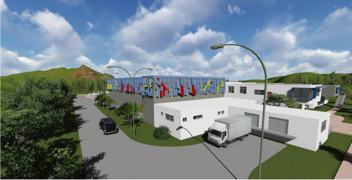
Vista lateral (este)
