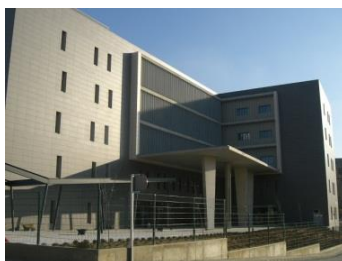
Figura 74. Marquesinas de ingreso.
