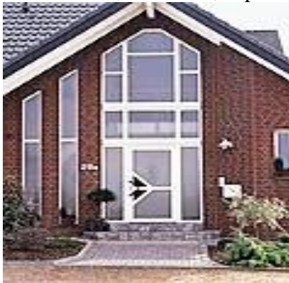
FOTO 12 Ingreso a residencia con ventanería de acero Fuente: (WILLIAMS, 1980)
