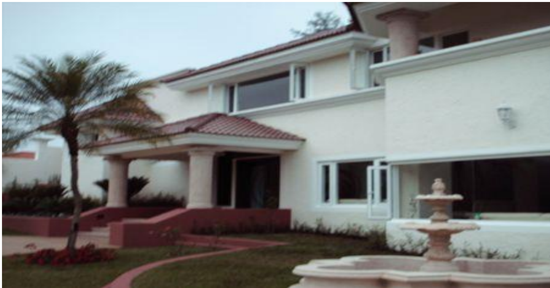
Foto 1 fachada con Ventanería de PVC fuente : propia 2014
