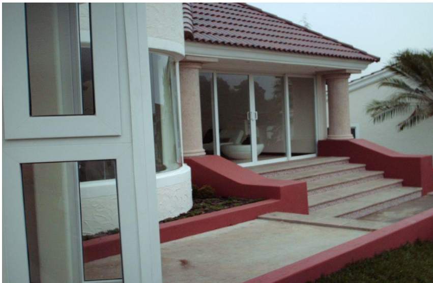
Fotografía 3 Puerta Corrediza y vidrio curvo perfilería de PVC. Fuente: propia 2014
