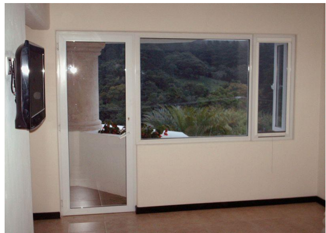
Foto 5 Puerta abatible, vidrio fijo y ventana abatible con perfil C-02 fuente Propia
