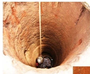
Excavación Manual.
