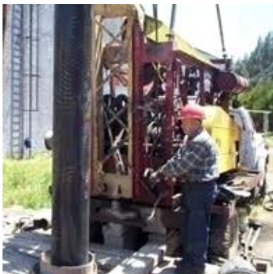
Colocado de tubos de encamisado de pozos.
