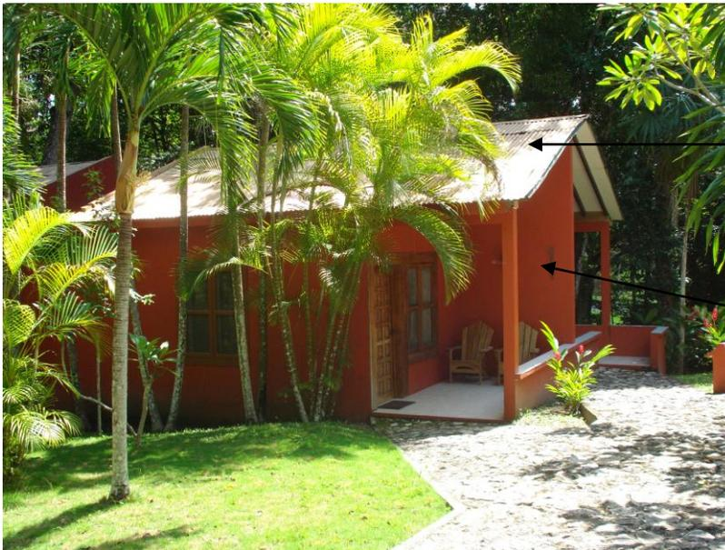
Para el techo a dos aguas, estructura de madera con cubierta de lámina de cinc con cielo falso de tabla yeso, las puertas de madera de caoba para las ventanas continúan de tipo paletas y vidrio y aluminio.
