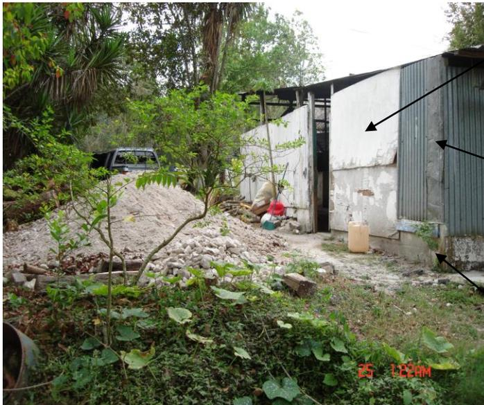
Utilizan como dormitorios para los trabajadores una galera, con techo de lámina de cinc a un agua, con pendiente insuficiente para las lluvias. Como muros utilizan lámina de cinc y planchas de madera de un 1/4", como protección de la lluvia elevan del nivel del suelo una combinación de manposteria y muro de bajareque.
