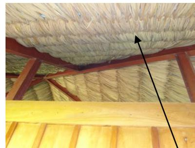
En el techo a cuatro aguas existe una combinación de estructura de metal columnas "I" y vigas "I" y la cubierta de palma de guano.
