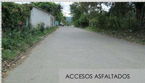
ACCESO AL TERRENO
