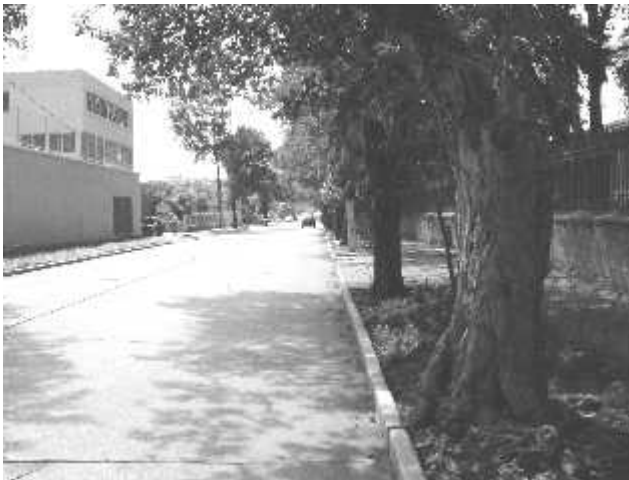
2ª. Avenida, Vía en un solo sentido
