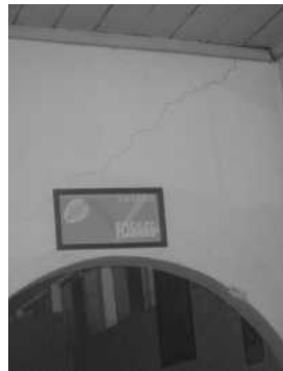
Paredes y vigas agrietadas.
