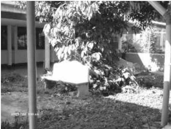
Áreas de jardín interior estado actual sin mobiliario adecuado y aún existe el área de caimanes que ya fueron devueltos al zoológico.
