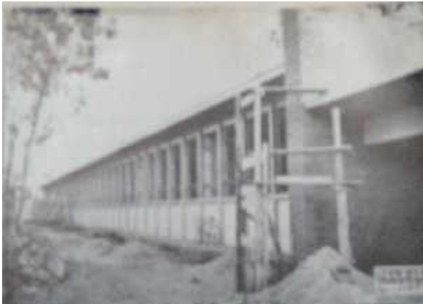
Inicio de la construcción del edificio de Ciencias Económicas Ingreso Fuente: Memoria de Labores 1950-54
