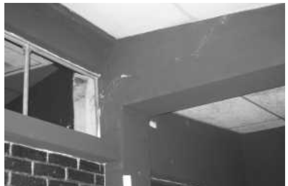
Paredes y vigas agrietadas.
