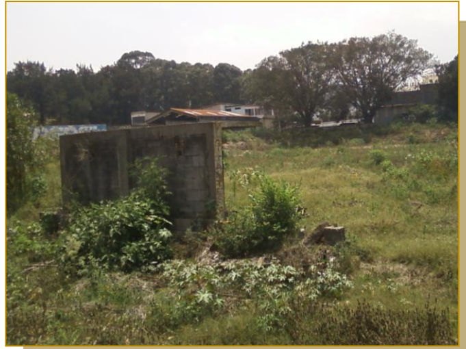
FOTOGRAFIA No. 20. Interior del terreno orientación sur.
