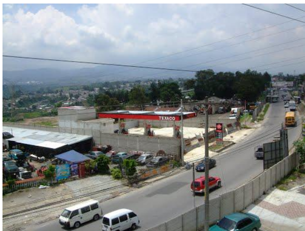
FOTOGRAFIA No. 13. Carretera que va de la Avenida Petapa hacia Villa Nueva, asfaltada en mal estado.
