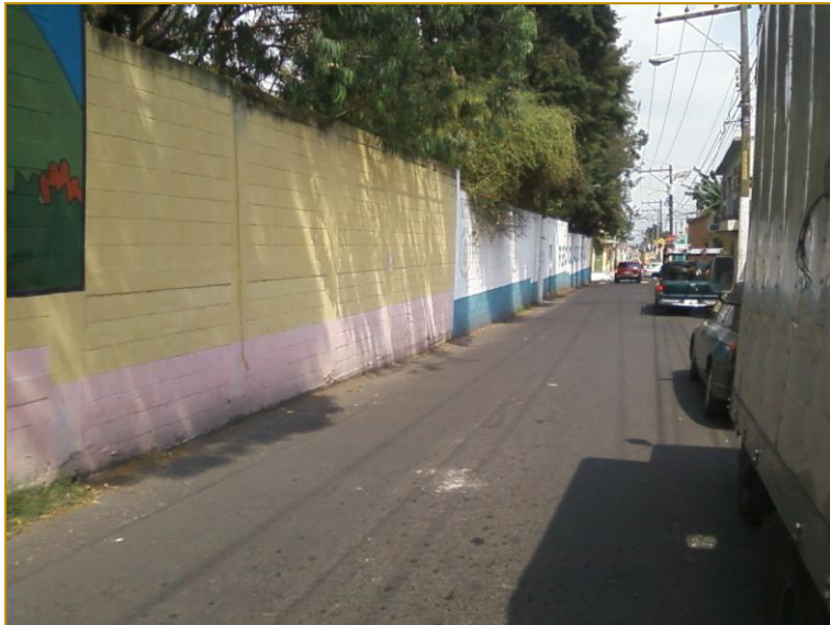
FOTOGRAFIA No. 23. Vía de acceso secundaria, orientación nor-oeste.
