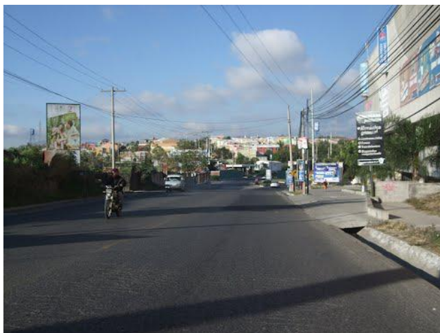
FOTOGRAFIA No. 12. Carretera que va del Frutal hacia Villa Nueva, asfaltada en mal estado.
