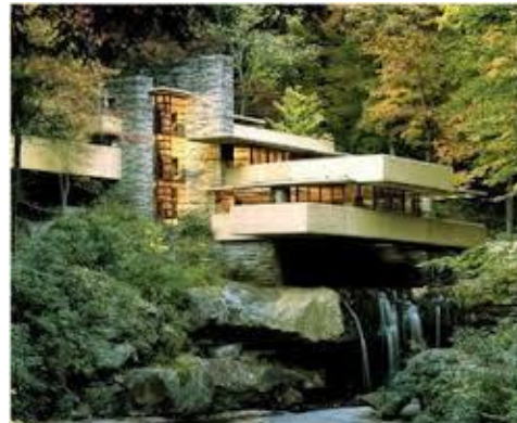
Imagen No.2: Casa de la Cascada, Frank Lloyd Wright ( http://www.cosasdearquitectos.com/2011/01/la-casa-de-la-cascada-frank-lloyd-wright/ )
