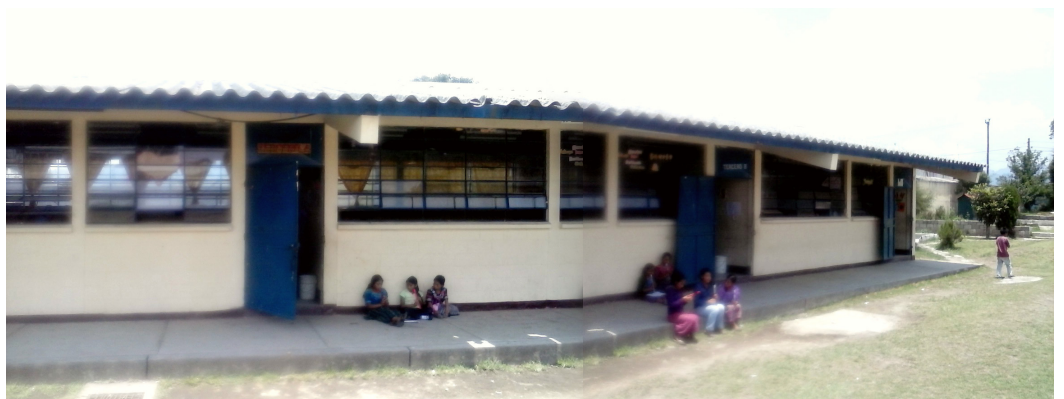
Aulas a renovar para uso de talleres.
