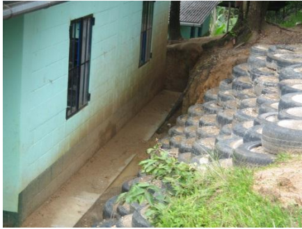
Descripción: Muros de contención. Fotografía: Aníbal Rodríguez, 31 de agosto 2013.
