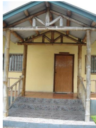
Descripción: Ingreso a edificación. Fotografía: Aníbal Rodríguez, 11 de septiembre 2013.
