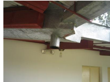
Descripción: Perfil metálico para la captación de agua de lluvia. Fotografía: Aníbal Rodríguez, 31 de agosto 2013.
