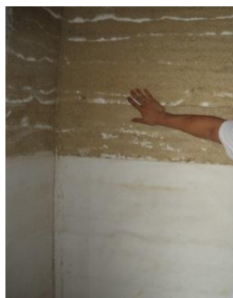
Descripción: Muro de tierra apisonada. Fotografía: Aníbal Rodríguez, 31 de agosto 2013.
