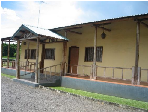
Descripción: Edificio de bambú y block. Fotografía: Aníbal Rodríguez, 11 de septiembre 2013.
