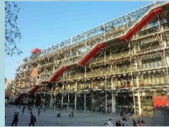
El Centre Pompidou, tiene todas las instalaciones de servicio hacia el exterior.
