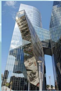
La nueva sede de Gas Natural en la Barceloneta Edificio de oficinas Barcelona, España EMBT
