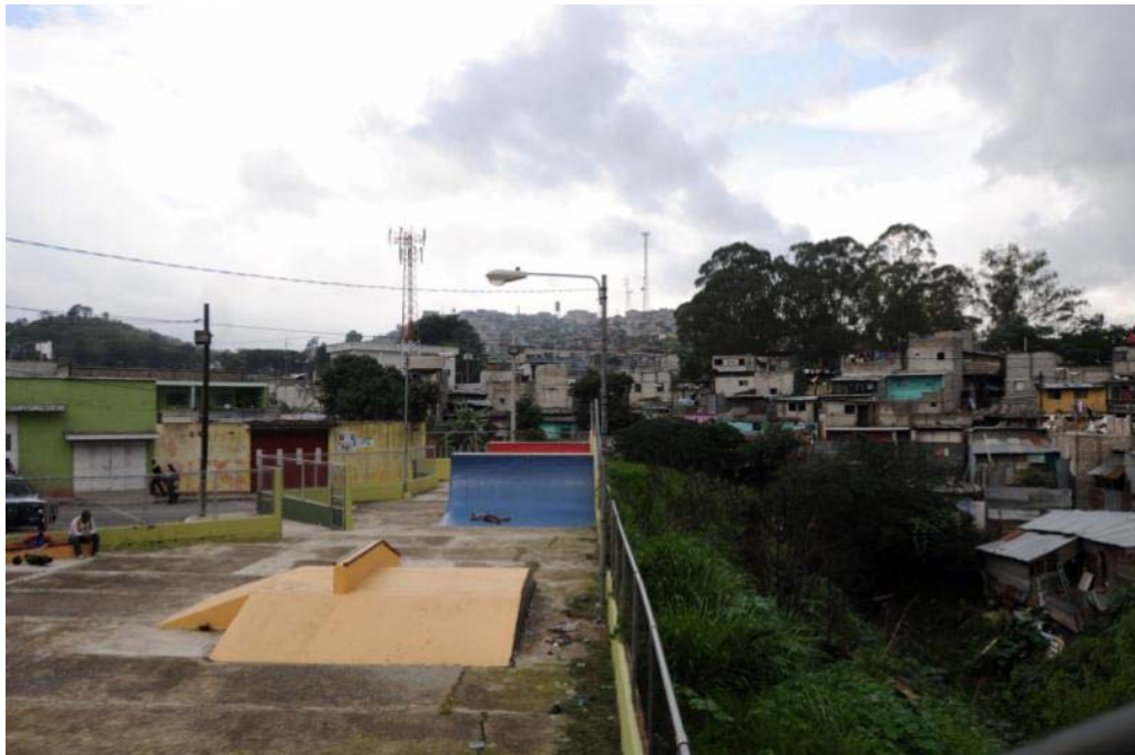
FOTOGRAFÍA D: Zona de Riesgo, Área Recreativa en área de riesgo
