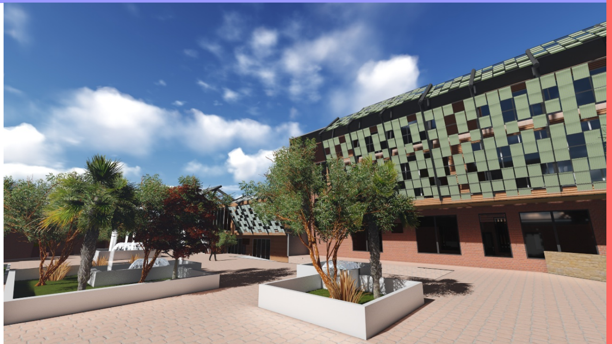
FACHADA SUR-EDIFICIO SECTOR INFANTO-JUVENIL
