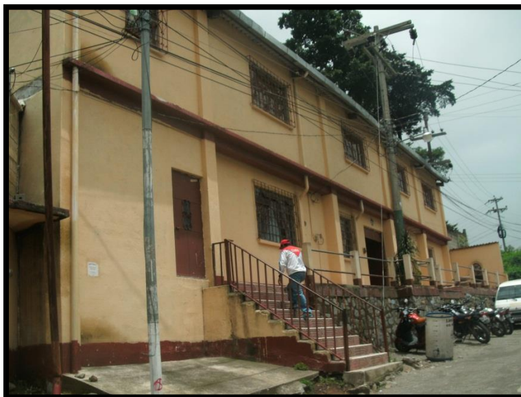
Fotografía No. 04 Fachada Frontal DIEDUC de Sololá
