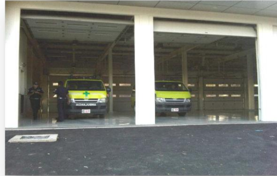
TIPO DE PORTONES CON UNA ALTURA NO MENOR A LOS 3.50MTS PARA EL INGRESO DE LAS UNIDADES
