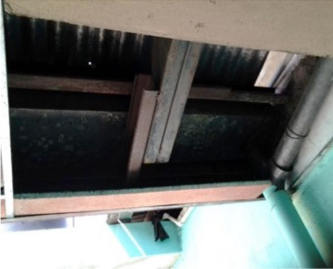
El inmueble presenta daño en la estructura del techo, ya que dicho techo ya no es el original, y ha sido reemplazado por estructura metálica, en ciertas partes del lugar las bajadas de agua están a la vista, están pintadas del mismo color de las paredes para que pasen desapercibidas.
