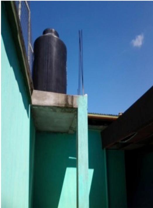
Para darle servicio de agua potable al inmueble se cuenta con un tanque elevado que ayuda a mantener el suministro de agua constantemente, está colocado en una losa hecha especialmente para el tanque, ya que no sigue la tipología constructiva del inmueble.
