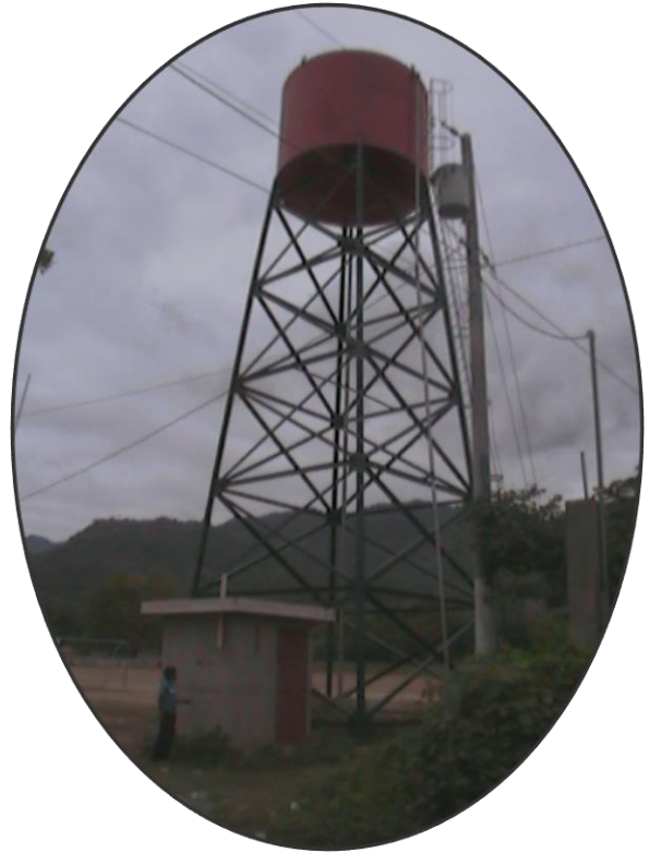
Foto No. 4 Servicios existentes en terreno municipal, agua potable, drenajes y energía eléctrica
