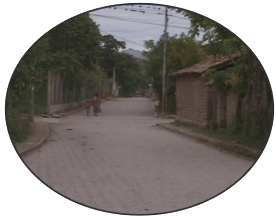
Foto No. 2 Camino hacia terreno municipal, calle de adoquín
