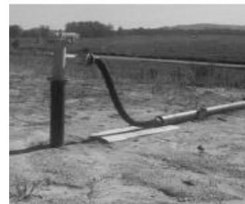
**Foto 3: Cabezal de dren horizontal**
