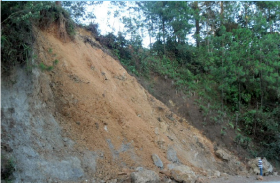
Gráfica No. 41 Derrumbe Sacquil
