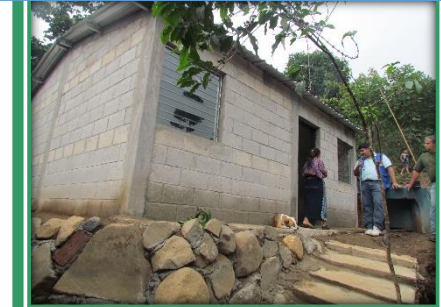
FOTOGRAFIA 31 VIVIENDA BENEFICIARIO DE CARITAS, BUENA VISTA SAN MARTIN SACATEPEQUEZ, QUETZALTENANGO FUENTE: ALONDRA GUZMAN FECHA: 24/6/14
