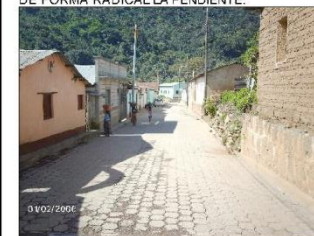
FOTOGRAFIA 2 EN ESTA DIRECCIÓN SE PUEDE OBSERVAR QUE TODAS LAS EDIFICACIONES UBICADAS DEL LADO DERECHO SE ENCUENTRAN ASENTADAS SOBRE UN TALUD FORMADO PARA PERMITIR EL PASO DE LA CALLE, LA CALLE CUENTA CON SISTEMA DE DRENAJE PLUVIAL LO QUE PROVOCA QUE EL AGUA DE LLUVIA SE DIRIJA HACIA LA IGLESIA.
