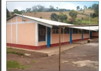
FOTOGRAFIA 1 AL FONDO LA FORMA DE LA MONTAÑA Y LA DEFORESTACIÓN OCASIONADA POR LOS AGRICULTORES DE MAÍZ. EN LA ORILLA DE LA EDIFICACIÓN SE NOTA UNA ZANJA QUE SE HA FORMADO DEBIDO A LA EROSIÓN PROVOCADA POR EL AGUA DE LLUVIA QUE CORRE A FLOR DE TIERRA.
