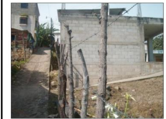
FOTOGRAFIA 1 LA PARTE TRASERA DE LAS AULAS SE ENCUENTRA A 70 CM. DE UN TALUD POR DONDE PASA LA CALLE, EL CUAL NO CUENTA CON PROTECCIÓN LO QUE HA OCASIONADO DERRUMBES.
