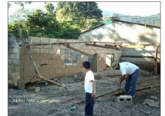
FOTOGRAFIA 3 LUEGO DE UN AÑO DE LA TORMENTA STAN, LAS VIVIENDAS CONTINUAN ENTERRADAS EN EL LODO QUE FUE ARRASTRADO POR EL RÍO.
