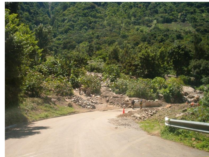
Fuente: Recorrido realizado en el trabajo de investigación, foto #1 tomada en el acceso desde el Km. 148 descenso hacia San Pablo La Laguna
