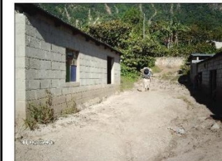
FOTOGRAFIA 2 EN LA PARED DE ESTA VIVIENDA SE OBSERVA EL NIVEL ALCANZADO POR EL FLUJO DE LODO, UNOS 80 CENTÍMETROS.
