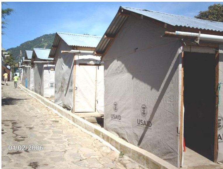
Foto #32 Viviendas temporales construidas por USAID. Fuente: Trabajo de campo realizado febrero 2,006
