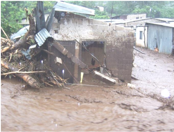
Foto #19 Esta vivienda se ubicaba en la esquina donde se unieron dos corrientes, se puede observar la fuerza de la corriente, así como los restos de árboles, piedras y materiales recogidos a su paso. Fuente: Informe de la situación ante el desastre del 5 octubre 2,005 elaborado por la Municipalidad de San Juan La Laguna.
