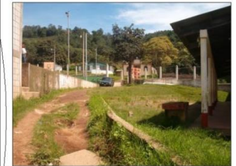
FOTOGRAFÍA 2 ESTA ES LA PARTE MÁS BAJA DEL EDIFICIO ESCOLAR POR LO QUE ES LA PARTE QUE CORRE MÁS RIESGO DE SER INUNDADA YA QUE ENTRE EL NIVEL DE LA CANCHA Y EL DEL MÓDULO 3 ES DE 2 METROS. AL FONDO LA FORMA DEL TERRENO Y EL TIPO DE VEGETACIÓN EXISTENTE.
