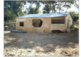
FOTOGRAFIA 1 ESTA VIVIENDA QUE SE UBICA FRENTE A LA IGLESIA PRESENTA DAÑOS GRAVES DEBIDO A LA CORRIENTE QUE BAJÓ POR LA QUEBRADA SECA. EL NIVEL DE AGUA SOBREPASÓ LOS 2 METROS DE ALTURA.
