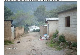
FOTOGRAFIA 3 AL FONDO PASÓ EL FLUJO DE LODO DURANTE LA TORMENTA STAN, DAÑANDO TODAS LAS EDIFICACIONES A SU PASO
