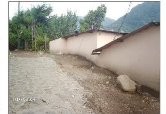
FOTOGRAFIA 2 EN ESTA FOTOGRAFÍA SE PUEDE OBSERVAR LA FORMA EN QUE ALGUNAS VIVIENDAS HAN SIDO CONTRUIDAS BAJO EL NIVEL DE LA CALLE ESTO ES DEBIDO A LA DIRECCIÓN DE LA PENDIENTE
