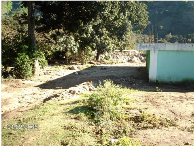
Foto #24 El nivel del lodo que la corriente arrastró e inundó la Escuela de Autogestión Comunitaria Barrio 5 de enero parte de atrás. Fuente: Trabajo de campo realizado febrero 2, 2006.
