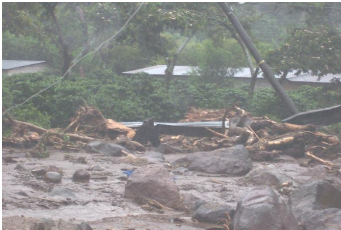
Foto #22 Se observa el tamaño de las piedras, árboles y restos de construcciones que fueron arrastrados por la corriente. Fuente: Informe de la situación ante el desastre del 5 octubre 2,005 elaborado por la Municipalidad de San Juan La Laguna.
