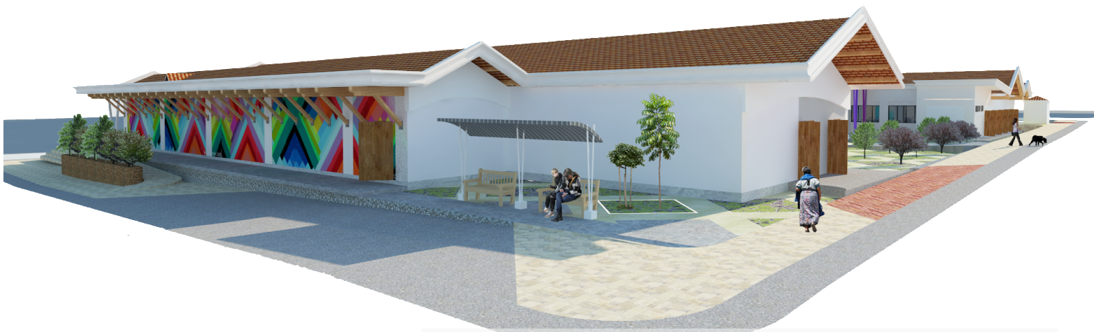
Vista No 1 Norte de Conjunto
