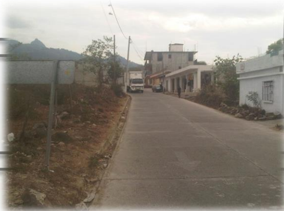
Fotografía A-1. Vista de Un tramo de Vía Primaria del Municipio de Palencia, la vía colinda con el terreno. Fuente: elaboración propia, Febrero 2015
