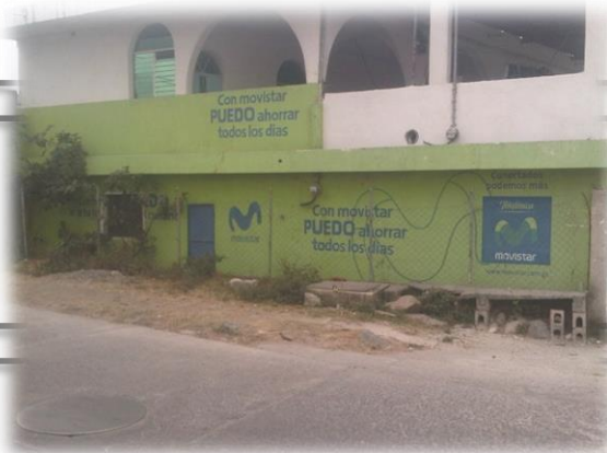
Fotografía A-3. Construcciones aledañas al terreno. Fuente: elaboración propia, Febrero 2015
