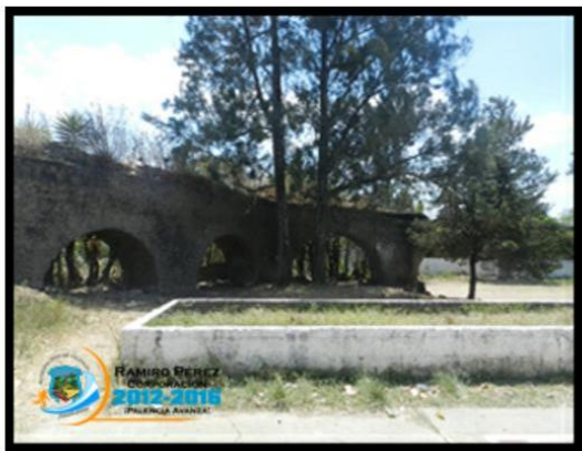
ANTIGUO ACUEDUCTO, ESCUELA TIPO FEDERACION No. 1 PALENCIA
