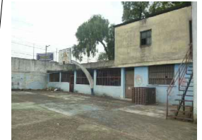
Foto 30. Construcción de Escuela
