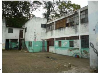
Foto 27. Construcción de Escuela
