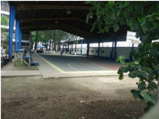
Posee instalaciones al aire libre y techadas, lo que permite hacer uso de ellas en cualquier época del año. La estructura que tiene es básicamente concreto reforzado, aunque en los graderíos y cubiertas tiene estructura metálica, que esta deteriorada.
