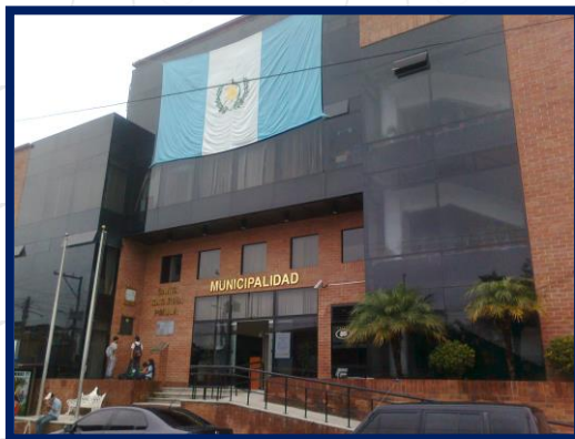
FACHADA PRINCIPAL MUNICIPALIDAD DE SANTA CATARINA PINULA. Fotografía No. 39 Fuente. Alejandro Gaytán S.
