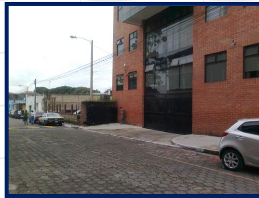
6º. AVENIDA ZONA 1, VIA SECUNDARIA HACIA LA MUNICIPALIDAD DE SANTA CATARINA PINULA. Fotografía No. 38 Fuente. Alejandro Gaytán S.
