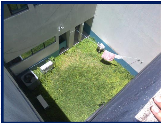
PATIO INTERIOR DE SERVICIO Fotografía No. 34 Fuente: Alejandro Gaytán S.
