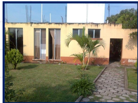
ENTRADA A TESORERÍA MUNICIPAL Fotografía 16 Fuente: Alejandro Gaytán S.
