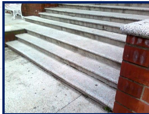
GRADAS ENTRADA PRINCIPAL Fotografía No. 42 Fuente. Alejandro Gaytán S.
