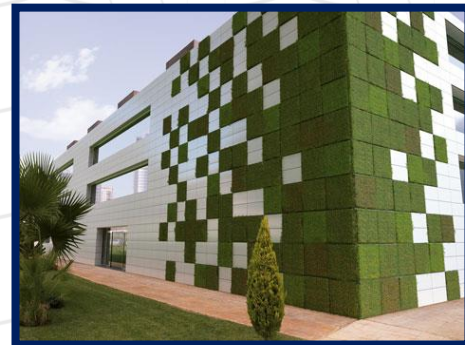
MUROS EXTERIORES CON VEGETACIÓN Imagen No. 19 Fuente: Galería Propia de Imágenes
