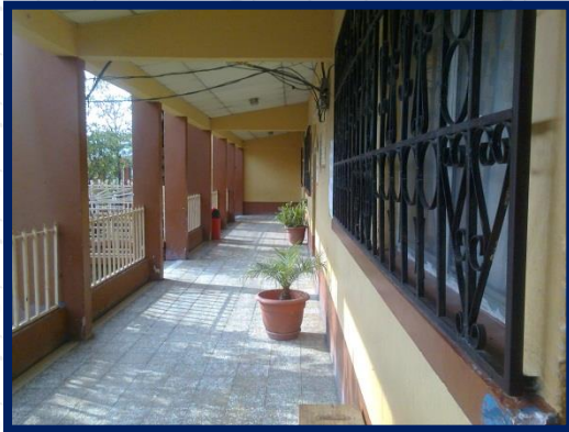
CORREDOR DE ENTRADA A LA MUNICIPALIDAD Fotografía 5, Fuente: Alejandro Gaytán S.
