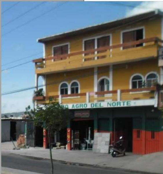
**Estructura de concreto y block, con altura de 2.80 m por nivel**
