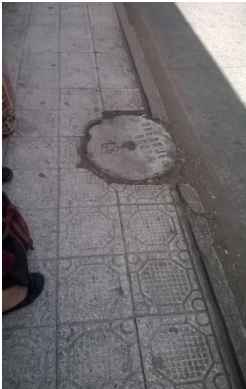
Figura 60 Banqueta con acabado de piso de cemento para exterior 2ª avenida de 7ª a 8ª calle. Fotografía propia (Amatitlán 2015)
