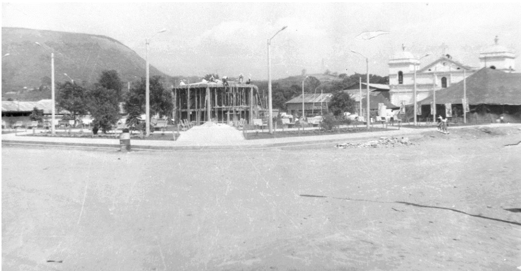
Figura 18 Construcción del kiosco del parque central (Amatitlán años 60 aproximadamente) Puede observarse que aún se realizan los trabajos de construcción del kiosco del parque central, se observa también la presencia de luminarias de mercurio y puede apreciarse el diseño original de las jardineras que se encuentran a nivel de piso. Al fondo se puede observar la instalación de una carpa de circo, la fachada del templo parroquial San Juan Bautista, la fachada del mercado central y otras edificaciones. Fuente http://www.miamatitlan.com/amatitlacuten-de-antantildeo.html (septiembre 2015)
