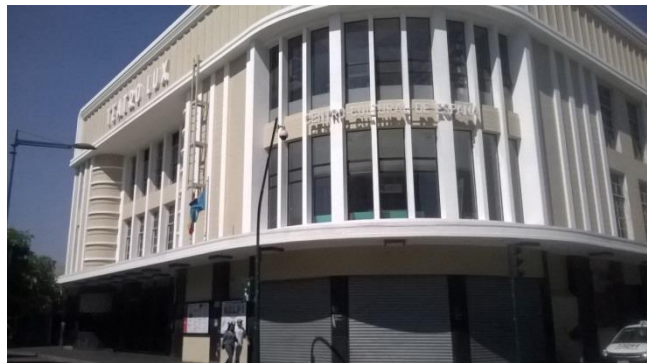
Figura 13 Edificio Centro Cultural de España, antiguo cine Lux. Fotografía propia (Paseo de la Sexta, Guatemala, 2015)
