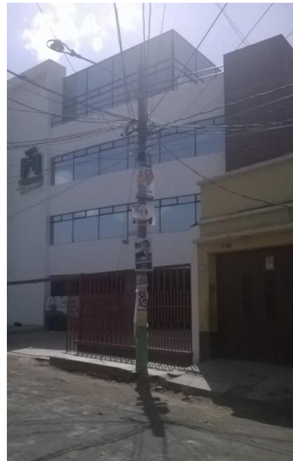
Figura 106 Poste de concreto con luminaria, también se observa la aglomeración de líneas eléctricas, 3ª Avenida de 7ª a 8ª calle. Fotografía propia (Amatitlán 2015)
