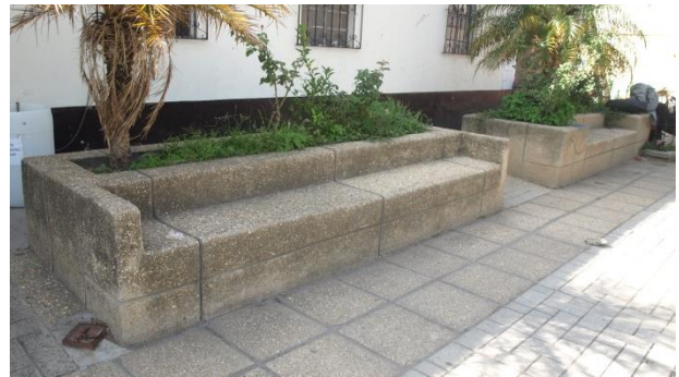
Figura 133 Banca de concreto lavado ubicadas en el área del parqucito parroquial. Fotografía propia (Amatlán 2015)
