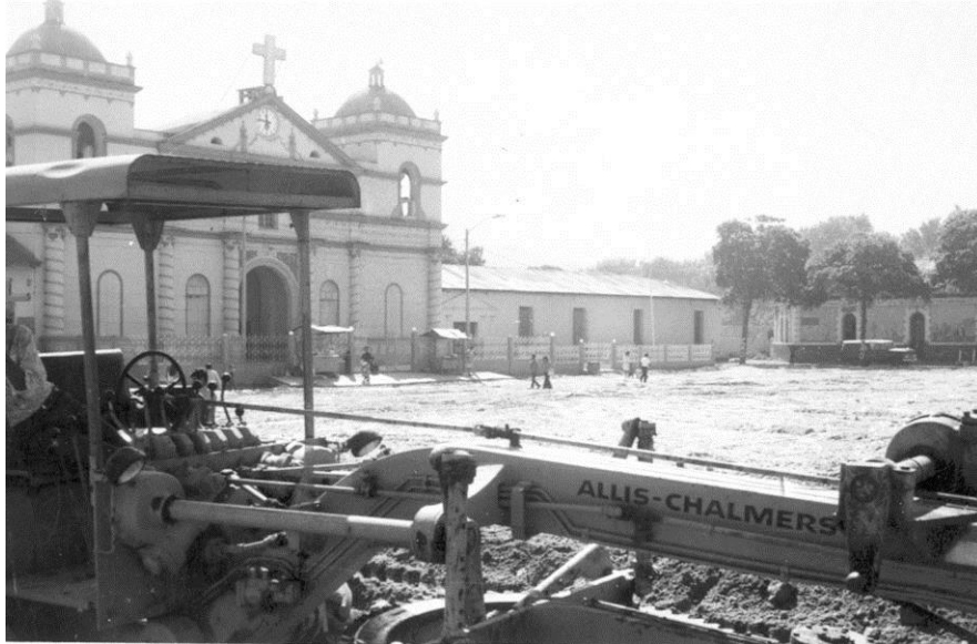
Figura 17 Máquina que realiza limpieza por presencia de lodo a causa de inundación (Amatitlán años 70 aproximadamente) Se observa al Fondo el templo parroquial San Juan Bautista, junto a él la casa parroquial con estilo arquitectónico tradicional del lugar, también puede verse la presencia de los árboles de almendros y detrás de ellos parte de la edificación de antiguo cuartel general. Fuente: http://www.miamatitlan.com/amatitlacuten-de-antantildeo.html (septiembre
