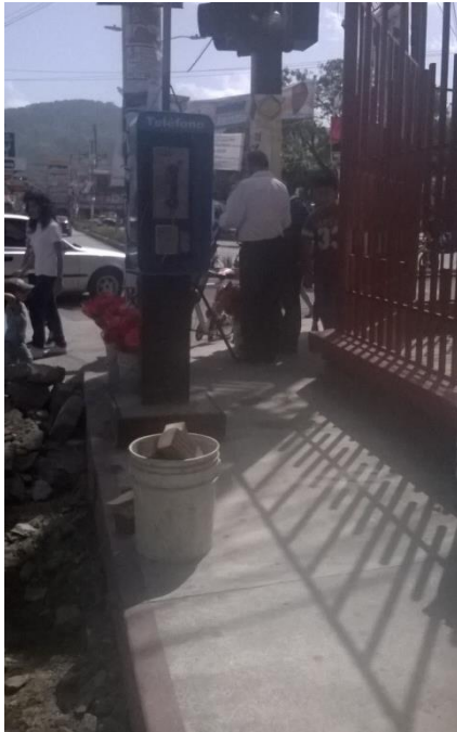
Figura 62 Banqueta de cemento en buen estado, 3ª avenida de 7ª a 8ª calle. Fotografía propia (Amatitlán 2015)
