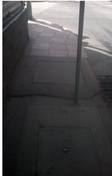
Figura 102 Caja tragante, ubicada sobre la rejilla de drenaje, esquina de la 3ª Avenida de 7ª calle. Fotografía propia (Amatitlán 2015)
