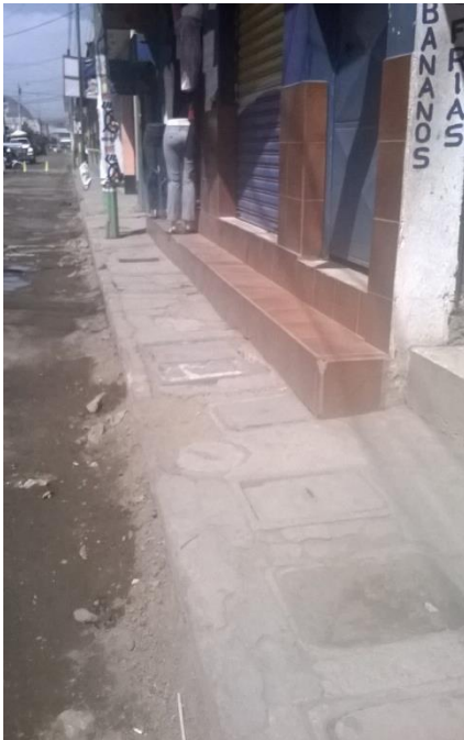
Figura 72 Sobre banquetas pueden encontrarse obstáculos como gradas de ingreso a inmuebles, 3ª avenida de 7ª a 8ª calle. Fotografía propia (Amatlán 2015)
