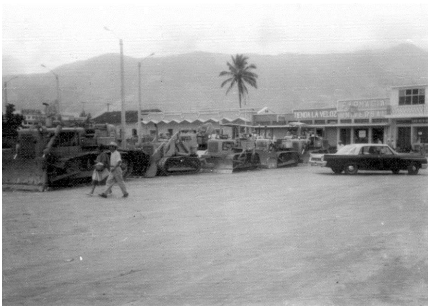
Figura 22 Trabajos de mejoramiento de 6ª calle (Amatitlán años 70 aproximadamente) detrás de la maquinaria puede observarse las edificaciones que se encuentran en la 3ª avenida entre 6ª y 7ª calle resaltado la presencia de nuevas edificaciones que sustituyen en estilo arquitectónico de las edificaciones características del lugar. Fuente: http://www.miamatitlan.com/amatitlaacuten-de-antantildeo.html (septiembre 2015)
