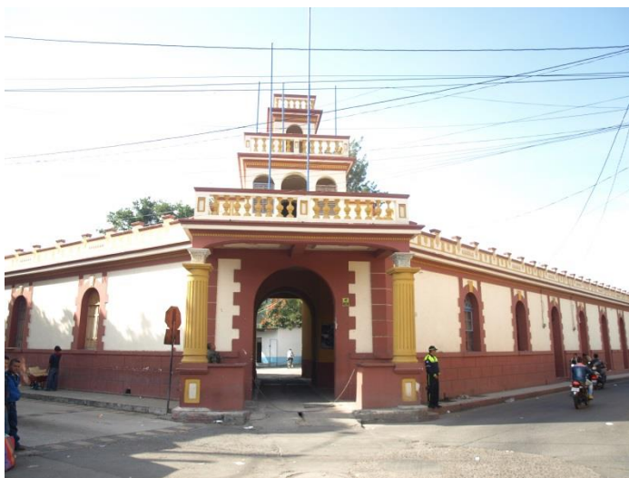
Figura 159 Edificio del antiguo cuartel general. Fotografía de Byron Melgar (Amatlán 2015)
