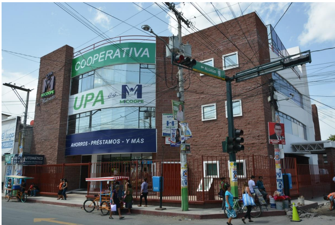
Figura 163 Edificio de las oficinas centrales de cooperativa UPA. Fotografía de Byron Melgar (Amatitlán 2015)
