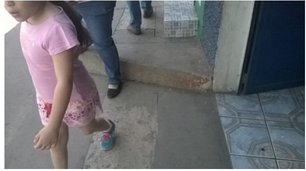
Figura 71 Ubicación de gradas en área de banqueta, 6ª calle de 3ª a 4ª calle. Fotografía propia (Amatlán 2015)
