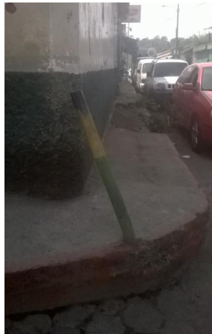
Figura 77 Ubicación de elementos metálicos para protección de inmuebles, este se encuentra deteriorado y dificulta el paso de peatones, esquina 3ª avenida y 8ª calle. Fotografía propia (Amatitlán 2015)
