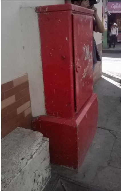
Figura 115 Caja telefónica tipo armario, ubicada en la 6ª calle y 3ª Avenida. Fotografía propia (Amatitlán 2015)
