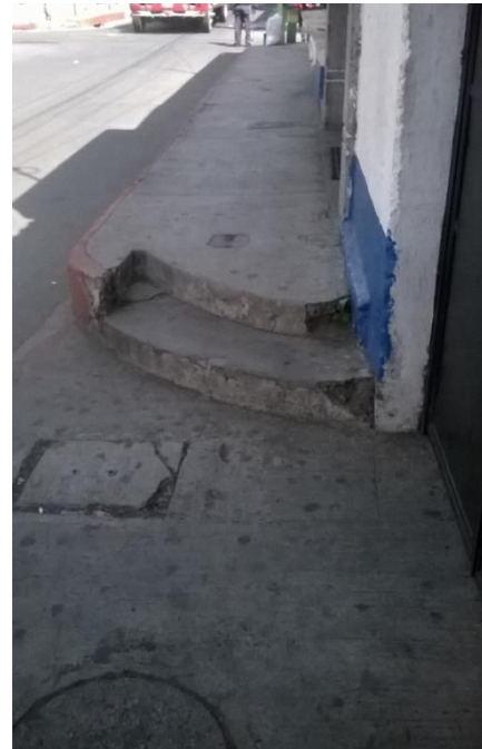
Figura 73 Debido a los cambios de niveles en banquetas se ubican gradas, 7ª calle de 3ª a 4ª avenida. Fotografía propia (Amatlán 2015)
