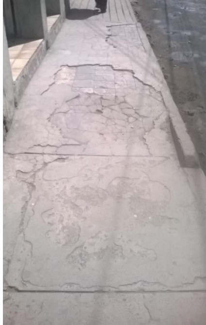
Figura 66 Banqueta con baches, 3ª avenida de 7ª a 8ª calle. Fotografía propia (Amatitlán 2015)
