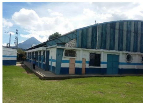
Vista exterior sur-este
