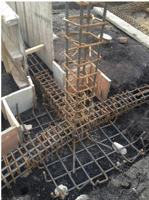
**ARMADO DE ZAPATA Y VIGAS DE AMARRE COMO CIMENTACIÓN.**
