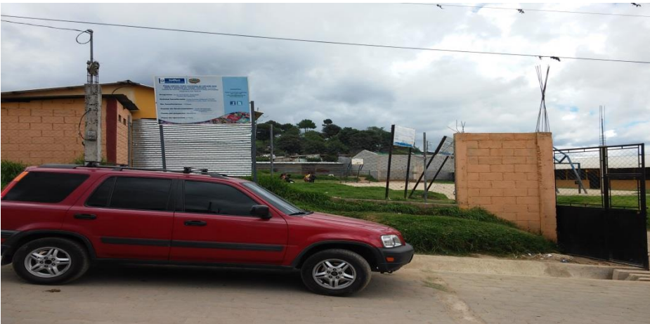
Imagen 8. Ingreso a la escuela, al fondo se observa el salón comunal. El ingreso principal al salón comunal se realiza por medio de un callejón de tres metros de ancho. Fotografía Manuel Montufar
