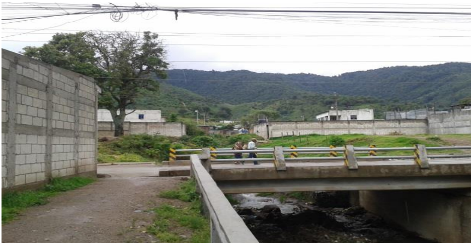
Imagen 13. Parte baja de la cuenca del río que atraviesa una calle adoquinada del casco urbano del municipio. Este puente fue destruido por la tormenta Stan en el año 2005. Fotografía Manuel Montufar
