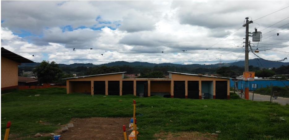
Imagen 10. Sobre la calle de ingreso a la escuela y al salón comunal se observa un poste con un transformador y un cable de alta tensión en la parte alta del mismo. Fotografía Manuel Montufar
