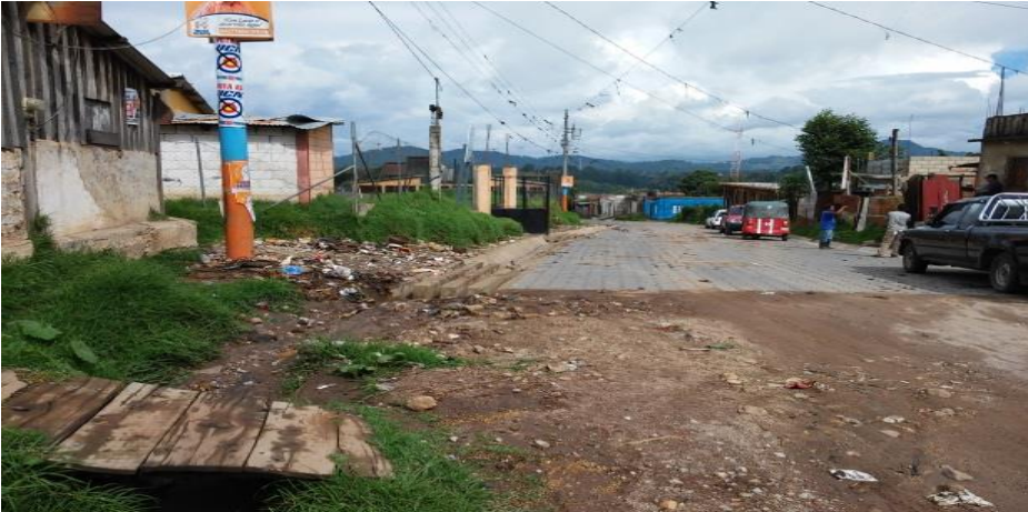
Imagen 7. Se observa la finalización de colocación de adoquín justo donde termina el área comunal del parcelamiento. Fotografía Manuel Montufar
