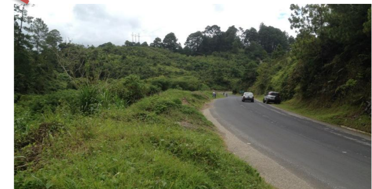
Fotografía 5. Calle Principal - Asfaltada
