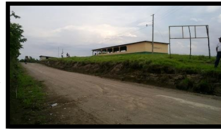
FOTOGRAFÍA CALLE PRINCIPAL. ANCHO DE CALLE 7.50M. TIPO DE CALLA BALASTRO. DOBLE VIA.
