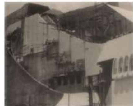
Vista de la construcción de la fachada oriente
