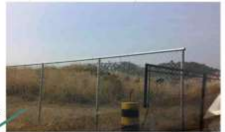
Imagen No. 42 Cerco perimetral en terreno del proyecto Fuente: Trabajo de campo
