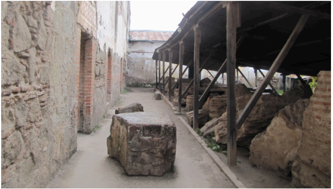
Corredor norte del claustro en el patio principal del Palacio Arzobispal.
