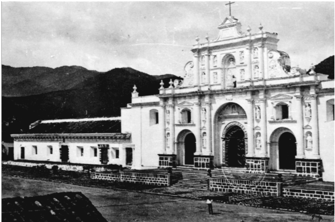
Fachada de la Catedral y Palacio Arzobispal, fotografía de fines del siglo XIX. (Archivo del Consejo Nacional para la Protección de La Antigua Guatemala) Obsérvese el Palacio Arzobispal en un nivel con techo de teja de barro a una vertiente, derrame exterior en las ventanas.
