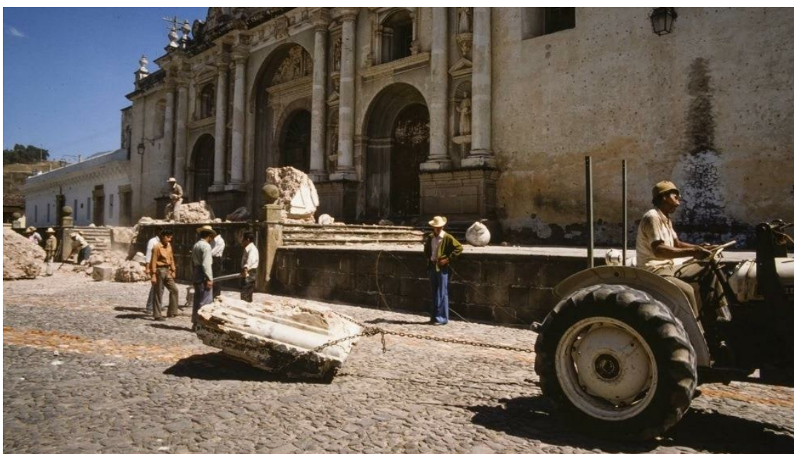
Arriba: Trabajos de limpieza de escombros frente a la fachada principal de la antigua Iglesia Catedral después del terremoto de 1976.
