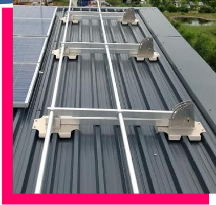
Las barandillas deben de cumplir con una serie de características ya que con esto aportara una seguridad adecuada al trabajador. Si se labora con frecuencia en determinada área, estas deben estar instaladas de forma permanente.
