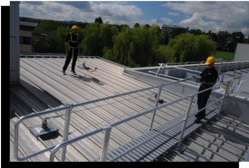
Las pasarelas son un elemento muy común en trabajos en cubiertas, estas deberían ser de fácil ensamblaje, para montajes rápidos. Así los trabajadores no se apoyarían sobre los techos o cubiertas de forma directa.
