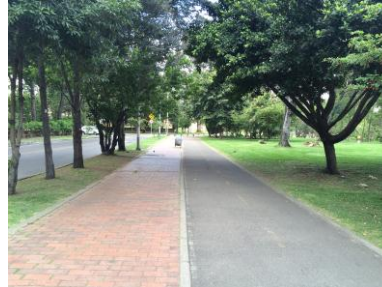
La Ciclo vía y la vía peatonal definidas por diferente material y textura
