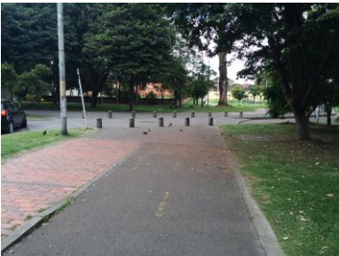
Los Bolardos separan la vía vehicular de la peatonal
