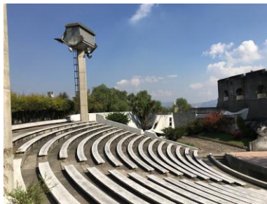
3 reflectores de audio e iluminación en la parte trasera, el graderío es para 1,500-1,800 espectadores
