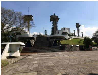
Ingreso principal del teatro al aire libre Otto René Castillo, vista desde la plaza del Centro Cultural
