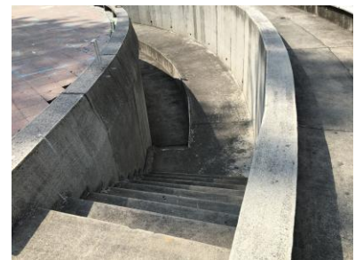
El foso de orquesta tiene 1.5m de profundidad aproximadamente
