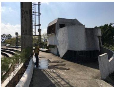
En la cabina se lleva el control del audio y de la iluminación del teatro
