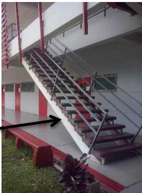
Estructura de acero
