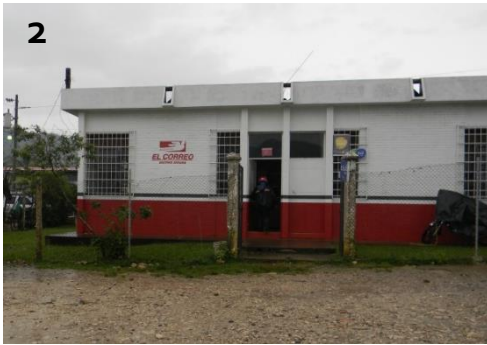
2 Edificio de correos
