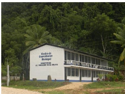
Uso Institucional, Centro de Capacitación Municipal Foto: Andrea Barrientos 31-08-2014
