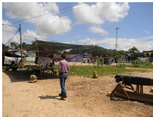
Vista de poste eléctrico y torre eléctrica
