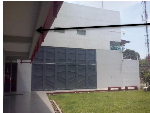
Vigas de concreto
