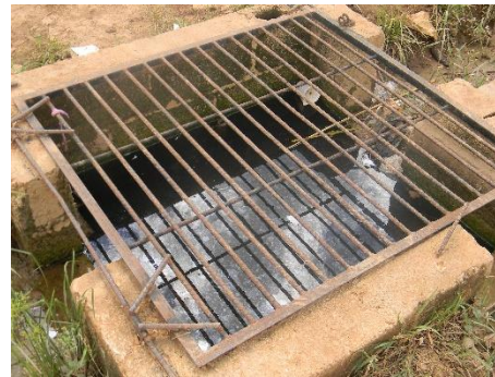
Vista de caja de registro, frente a la Franja Transversal del Norte
