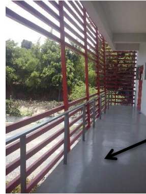
Piso de concreto
