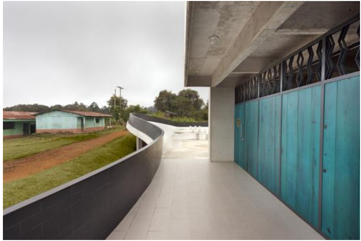
Figura 28. SEGUNDO NIVEL DE ESCUELA
