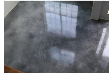
Figura 49 Piso de concreto pulido FUENTE: http://www.concretodecorado.com/cemento-pulido-microdelgado
