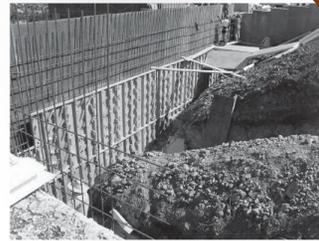
Figura 8.2 Muro de retención en voladizo en proceso de construcción. (Cortés de Thomas Malloy, Geotechnical Solutions, Inc., Irvine, California.)
