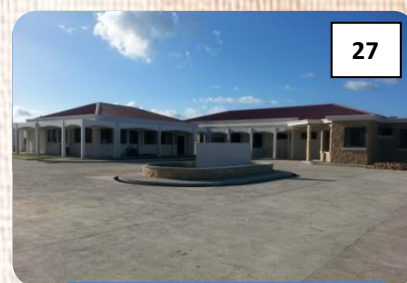
Centro de Atención Permanente -CAP- El edificio presenta una arquitectura clásica con características del periodo colonial, techos a cuatro aguas, arcos rebajados, cenefas con pecho de paloma y muros en mampostería alisados.
