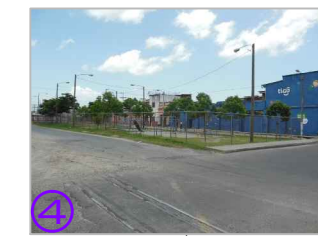
4 IMAGEN DE ELABORACIÓN PROPIA: SOBRE LA 12 CALLE "A", SE OBSERVA LA TRAZA DEL SITIO, ESTA ES ORTOGONAL, SOBRE LA AVENIDA PRINCIPAL DEL PROYECTO (AVENIDA FERROCARRIL), EXISTE UN AMPLIO GABARITO QUE SE EXTIENDE SOBRE LA 10 CALLE HASTA LA 17 CALLES, EL CUAL PODRÍA TENER UN NUEVO CARRIL VEHICULAR MÁS ACERA PEATONAL.
