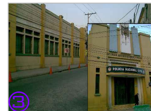
IMAGEN DE ELABORACION PROPIA; SE VISUALIZA EL EDIFICIO CORRESPONDIENTE A LA ANTIGUA ADUANA, EL CUAL HOY EN DIA LO OCUPA LA DIRECCION GENERAL DE LA P.N.D. UBICADO SOBRE LA 10 CALLE ENTRE AVENIDA FERROCARRIL Y 13 AVENIDA DE LA ZONA 1.
