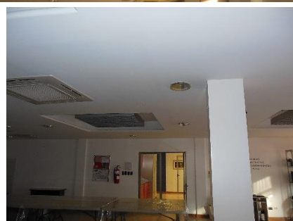
IMAGEN DE ELABORACIÓN PROPIA: SE OBSERVA EL USO DE CIELO FALSO PARA PERMITIR LAS INSTALACIONES ESPECIALES EN TODAS LAS ÁREAS.
