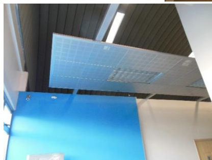
IMÁGENES DE ELABORACIÓN PROPIA: EN LAS IMÁGENES DE IZQUIERDA Y CENTRO SE OBSERVA EL TECHO DE LÁMINA CURVA REVESTIDO EN SU TOTALIDAD CON FIBRA DE VIDRIO, EN LAS ÁREAS DE PASILLOS SE HA COLOCADO UN CIELO FALSO SUSPENDIDO PARA MANTENER UNA ESCALA ADECUADA EN ESTAS ÁREAS.
