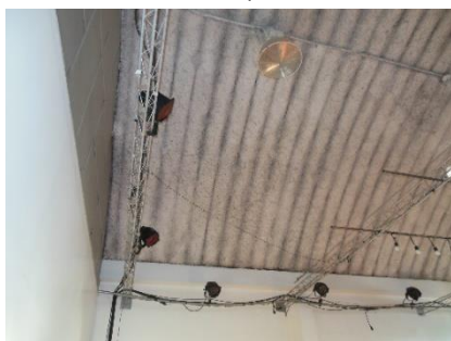
IMÁGENES DE ELABORACIÓN PROPIA: EN LAS IMÁGENES DE IZQUIERDA Y CENTRO SE OBSERVA EL TECHO DE LÁMINA CURVA REVESTIDO EN SU TOTALIDAD CON FIBRA DE VIDRIO, EN LAS ÁREAS DE PASILLOS SE HA COLOCADO UN CIELO FALSO SUSPENDIDO PARA MANTENER UNA ESCALA ADECUADA EN ESTAS ÁREAS.
