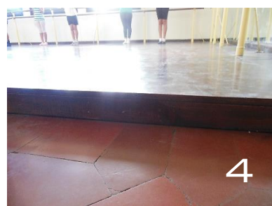
IMAGEN 4 – ELABORACIÓN PROPIA: TALLERES DE DANZA, NOTESE LA DUELA DE MADERA SOBREPUESTA EN PISO ANTIGUO.
