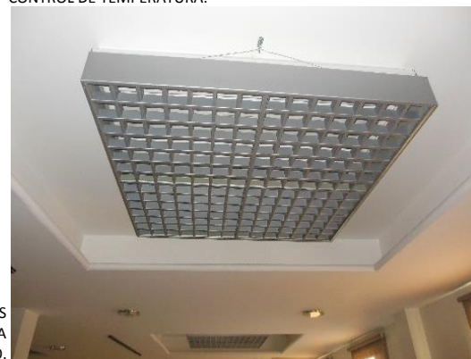
IMAGEN DE ELABORACIÓN PROPIA: SE OBSERVA UNO DE LOS DUCTOS DEL AIRE ACONDICIONADO, LOS CUALES ENCONTRAMOS EN LA MAYORÍA DE LOS AMBIENTES DE ARTECENTRO. CADA AIRE ACONDICIONADO DE CADA UNA DE LAS ÁREAS TIENE SU PROPIO CONTROL DE TEMPERATURA.
