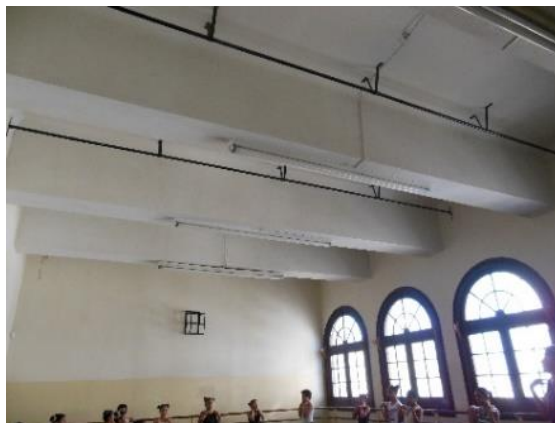
IMAGEN DE ELABORACIÓN PROPIA: SALÓN DE DANZA CLÁSICA, NÓTESE LA ESTRUCTURA DEL EDIFICIO CORRESPONDIENTE A UN SISTEMA DE TIPO MASIVO, LAS VIGAS Y LA LUZ ENTRE ESTAS, ASÍ COMO LA ALTURA DE LOS SALONES.
