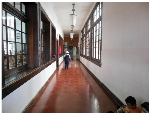
IMAGEN DE ELABORACIÓN PROPIA: PASILLOS DEL SEGUNDO NIVEL, SE OBSERVA LA AMPLITUD DE LOS MISMOS, SIN EMBARGO NO HAY SALIDAS DE EMERGENCIA Y EL TRAYECTO HACIA LAS SALIDAS CONVENCIONALES ES LARGO.
