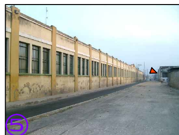
IMAGEN DE ELABORACIÓN PROPIA. FRENTE AL INMUEBLE DE LA ANTIGUA AGUANA QUE OCUPA TODA LA EXTENSIÓN DE LA 12 CALLE Y AVENIDA FERROCARRIL, EL CUAL ES DE 8.50MT DE ANCHO.
