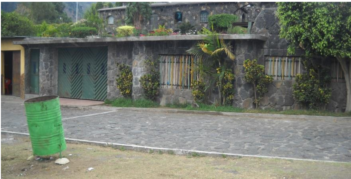
Fotografía 1 Edificio actual de la Asociación de Remo y Canotaje de Sololá Fuente: Fotografía propia
