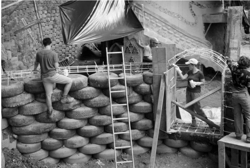
Figura 18. Sistema EARTHSHIP en proceso de construcción
