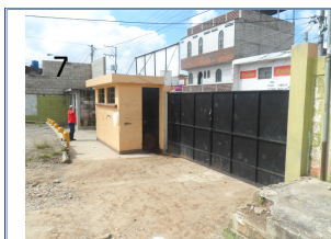
7 Localización garita de ingreso. Mejorar instalaciones y mejorar ingresos peatonales.
