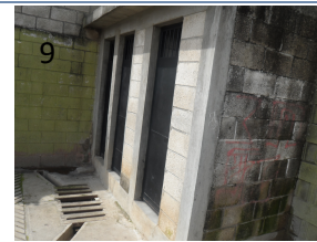
9 Localización baños públicos. Demolición de los mismos.
