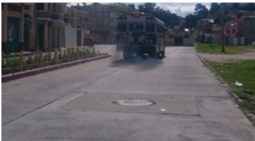
Imagen A . área de accesibilidad libre y adecuada al Sur-Oeste del solar, como se observa en la parte derecha de la imagen.
