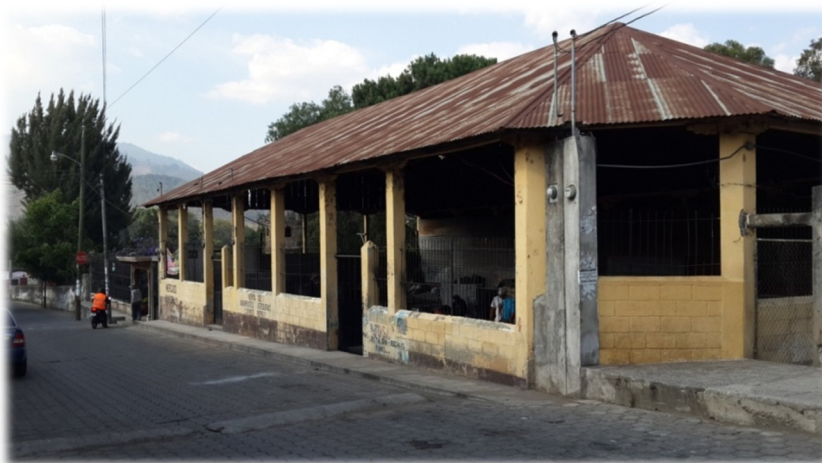
Foto 34: Frente del antiguo Mercado Municipal. Fuente: Archivo propio
