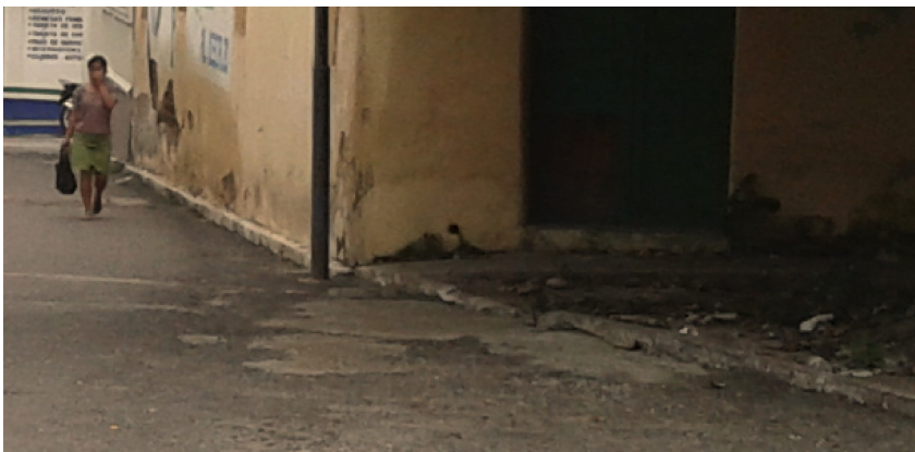
Figura 16. Se muestra la falta distinción entre la vía vehicular y la peatonal, calle cercana a parque central.
