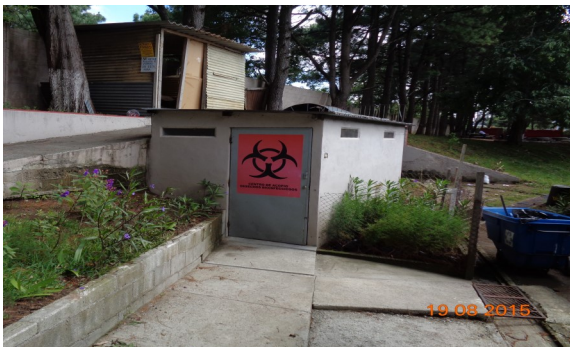
Figura 36. Deposito desechos bioinfecciosos.
