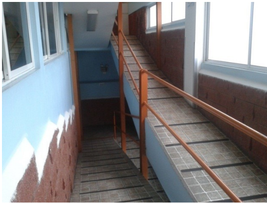
Figura 42. Rampa de intercomunicación entre niveles de hospital.
