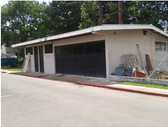
Figura 35. Área de máquinas, bomba hidroneumática, área de purificación de agua extraída de pozo perforado, planta eléctrica, área de taller y reparación de objetos.
