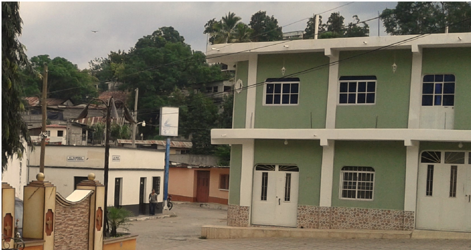
Figura 14. Se indica calles aledañas a la Municipalidad e Iglesia, la cuales tiene en su mayor porcentaje un sistema constructivo de mampostería.
