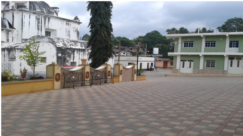
Figura 5. Pavimento e Iglesia frente a Municipalidad de San Juan Ermita. Fotografía imagen propia (Chiquimula, San Juan Ermita 2014)
