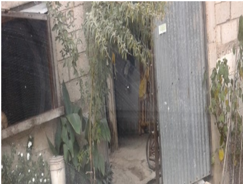
Figura 2. Se muestra el tipo de acabado en vivienda.
