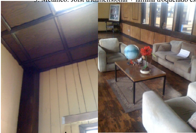
Figura 44: El sistema constructivo de madera está en la fachada principal de la dirección, y se observa que aún se mantiene en buenas condiciones, a pesar del recorrido del tiempo. El sistema contempla: columnas, muros, losa (acabado de cielo falso), y piso (parquet). Fuente: Propia.
