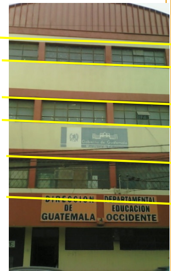
Figura 67: El diseño de las ventanas en las oficinas, se puede observar que están a una altura de 2.70m aproximadamente y sobre el nivel del piso, haciendo que la incidencia no afecte al personal. Fuente: Propia.
