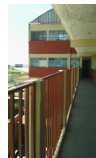
Figura 68: El inmueble posee un pasillo en todos sus niveles, cumpliendo la función de voladizo para evitar la incidencia solar. Fuente: Propia.
