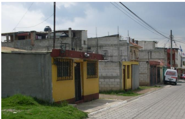
Fotografía No 16 Materiales predominantes en la vivienda, (2014). Colonia Los Trigales, zona 6 de Quetzaltenango.
