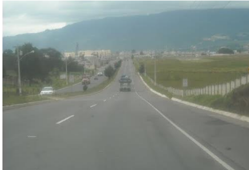
Fotografía No 22 Autopista Los Altos, (2015). Zona 6 de Quetzaltenango.
