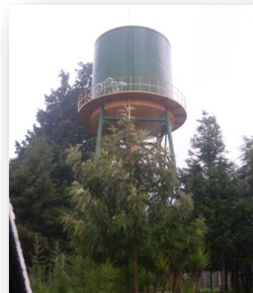
Fotografía No 7 Tanque de agua, (2015). Colonia Los Trigales, zona 6 de Quetzaltenango.
