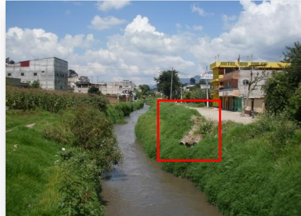
Fotografía No 24 Descargas de drenaje, Río Seco (2014) zona 6.
