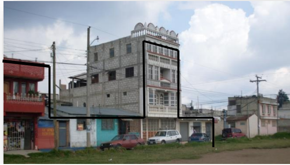
Fotografía No 17 Altura en Edificabilidad, (2014).
